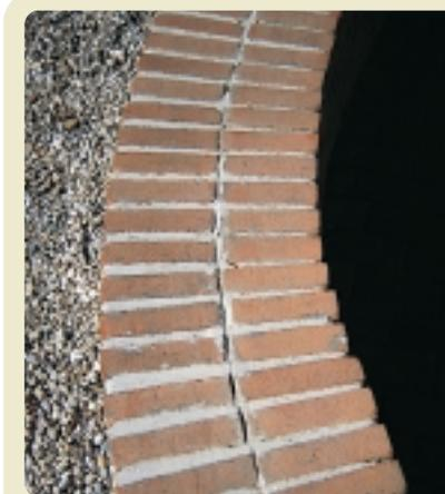
LA POSA SENZA FILI DI CONTROLLO PORTA AD UN'ESECUZIONE POCO REGOLARE DI GIUNTI E ALLINEAMENTI
